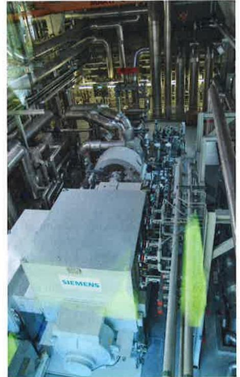
Die Stadtberner Kehrlichtverbrennungsanlage Forsthaus ist mit einem Gaskombikraftwerk und einem Holzheizkraftwerk kombiniert. Nicht nur Wärme wird hier erzeugt, sondern mithilfe dieser Dampfturbinen auch Strom. Während des Betriebs verbraucht das HHKW täglich etwa 1000 SRm Holzschnittel.
